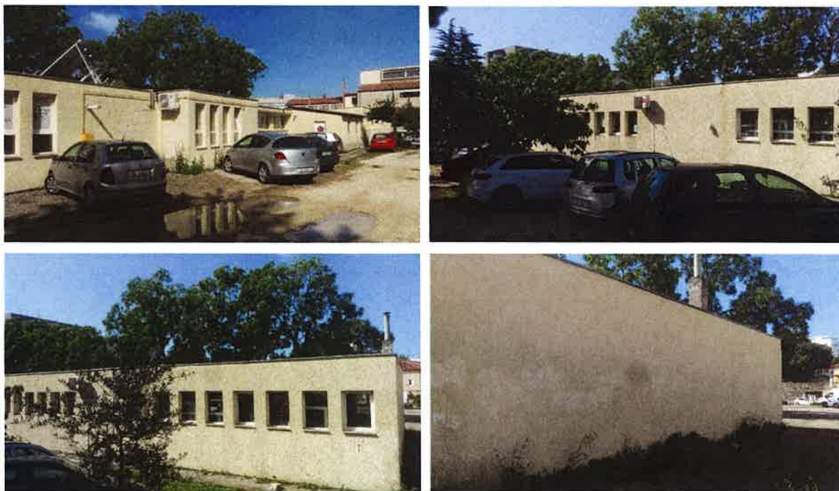
Slika 1. Sjeveroistočno i sjeverozapadno pročelje zgrade škole
