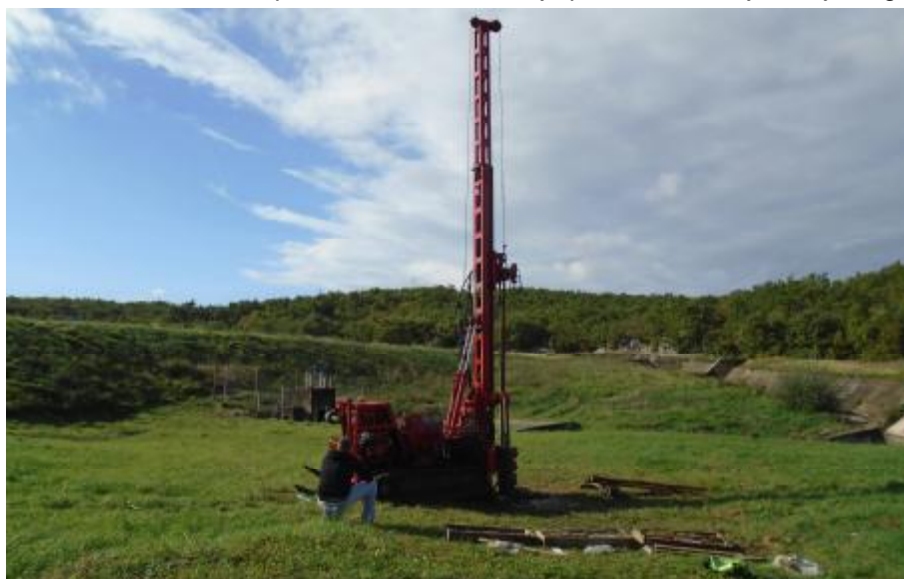
Izvođenje istražnog bušenja na poziciji CS Grabovac.
